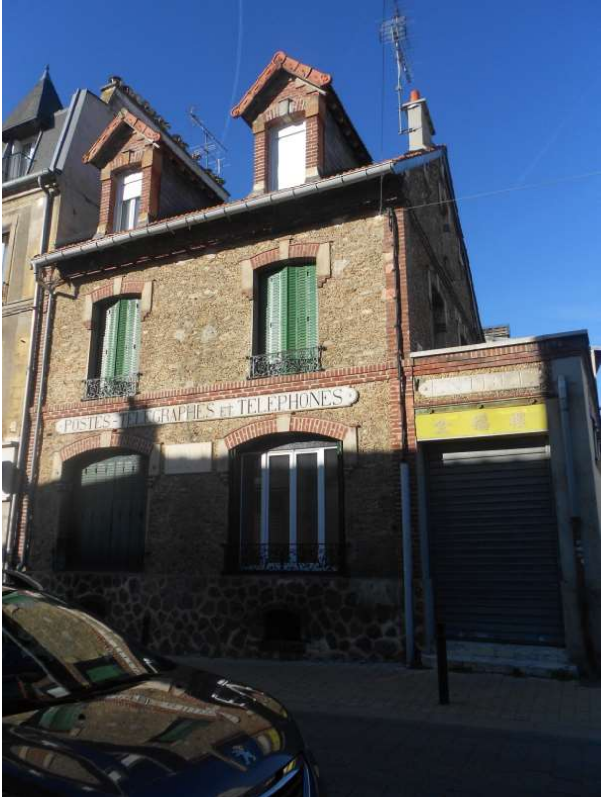
Le bureau de Poste et Télécommunication transformé en restaurant chinois (comme on peut le voir à droite de la photo)
