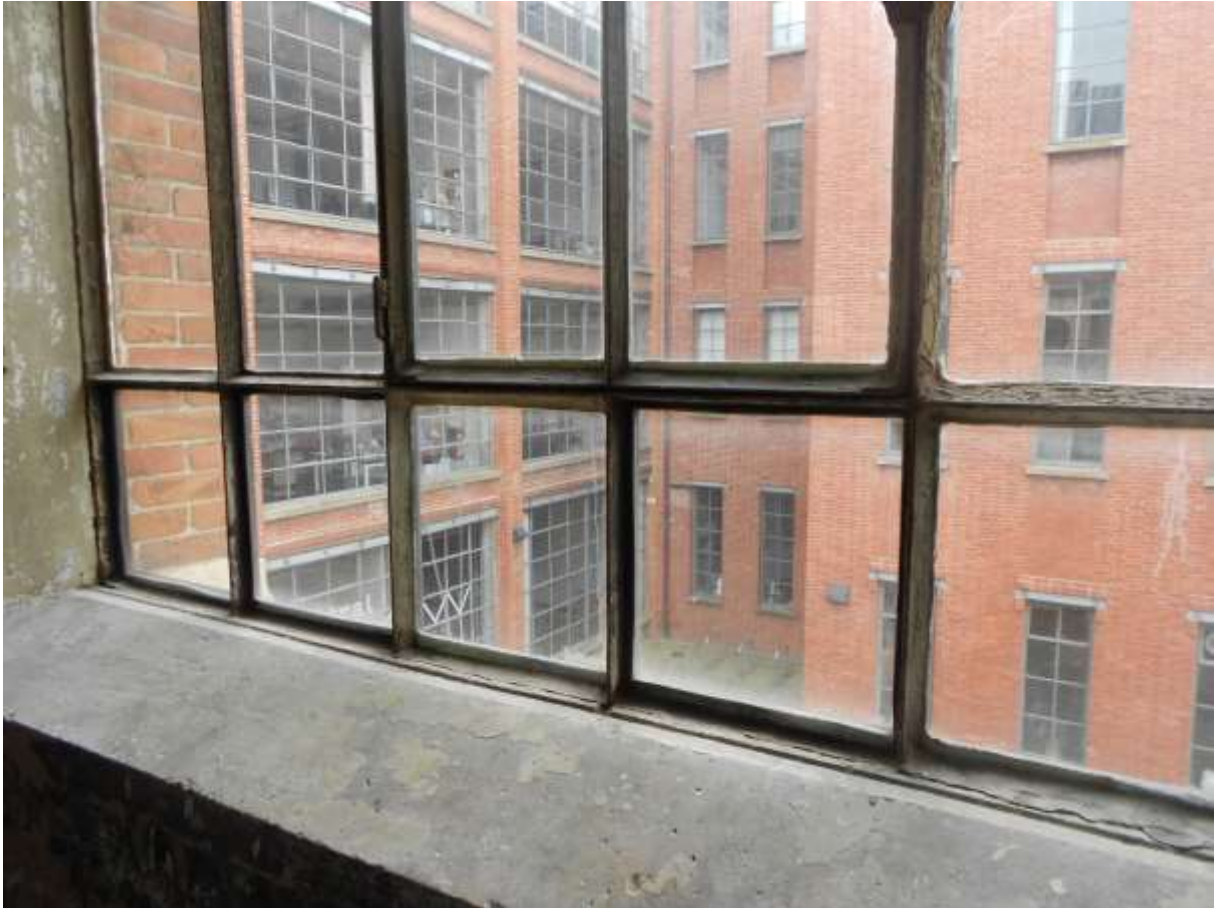
Vue sur la partie états-unienne de l'usine
